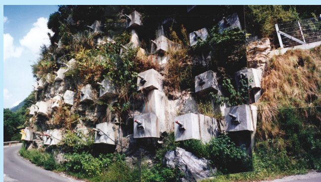
道路側面の自然法面補強
