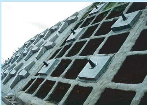
既設法枠内施工
