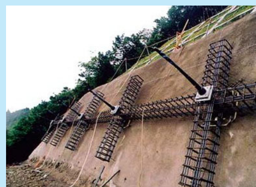
法枠と鋼製支圧板の併用
