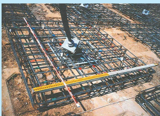
アンカーを斜めに設置
